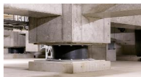
免震装置 建物に地震が直接伝わることを防ぎ、災害から人命、施設を守ります。
